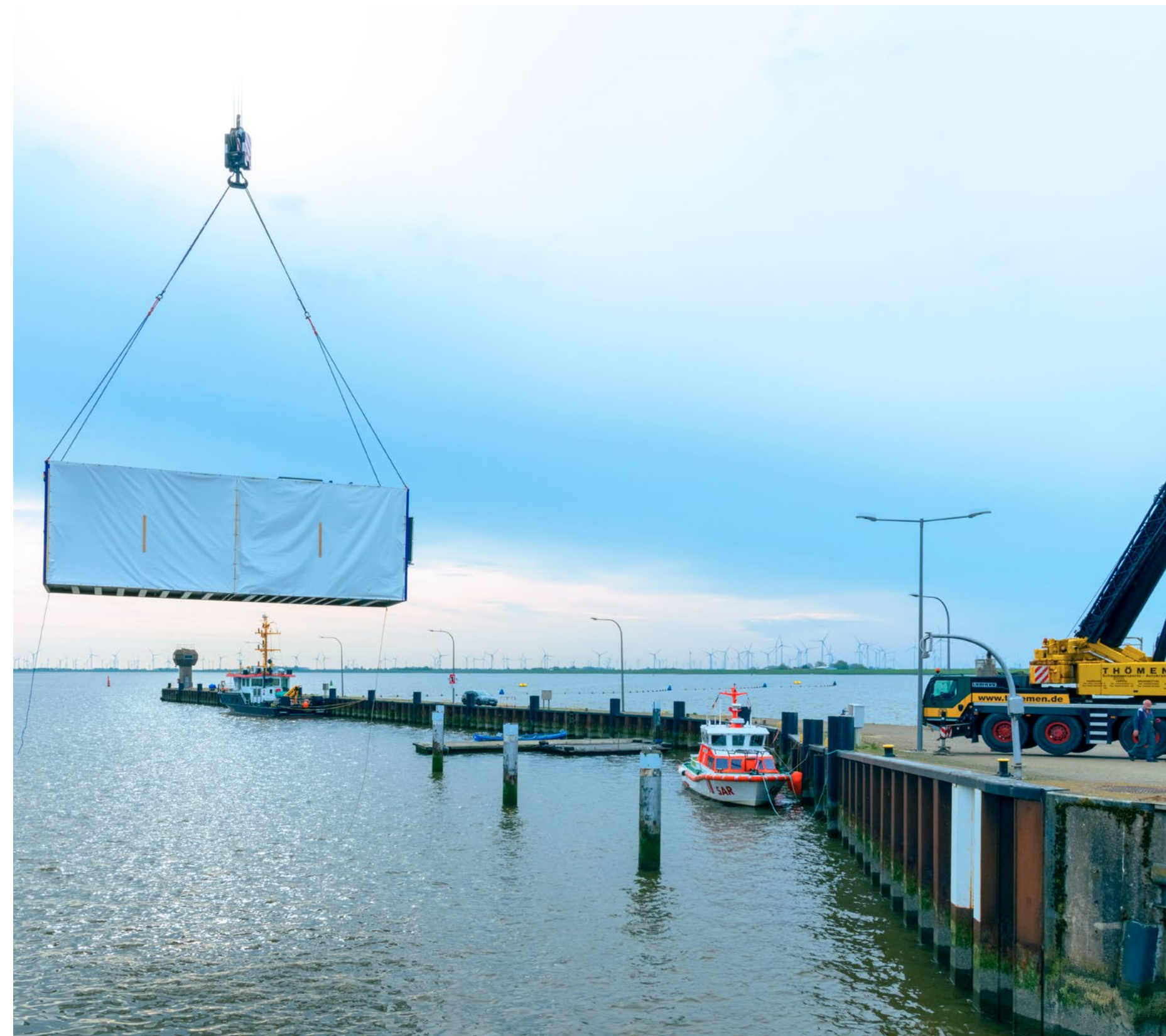
Aufbau des Meerwasserlabors direkt an der Nordsee
