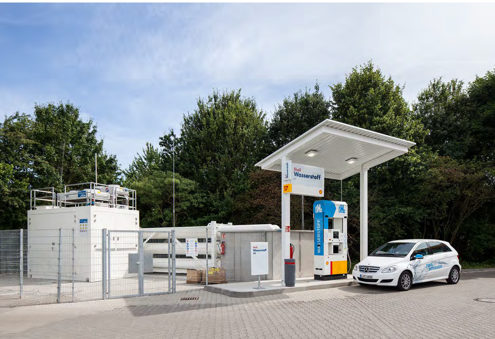
Wasserstoff-Tankstelle in Wiesbaden
