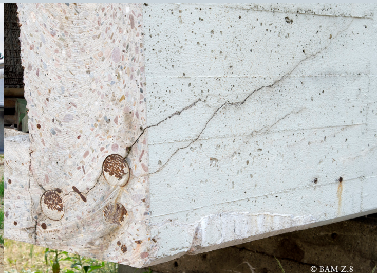
Originaler Brückenträger mit Rissbildung
