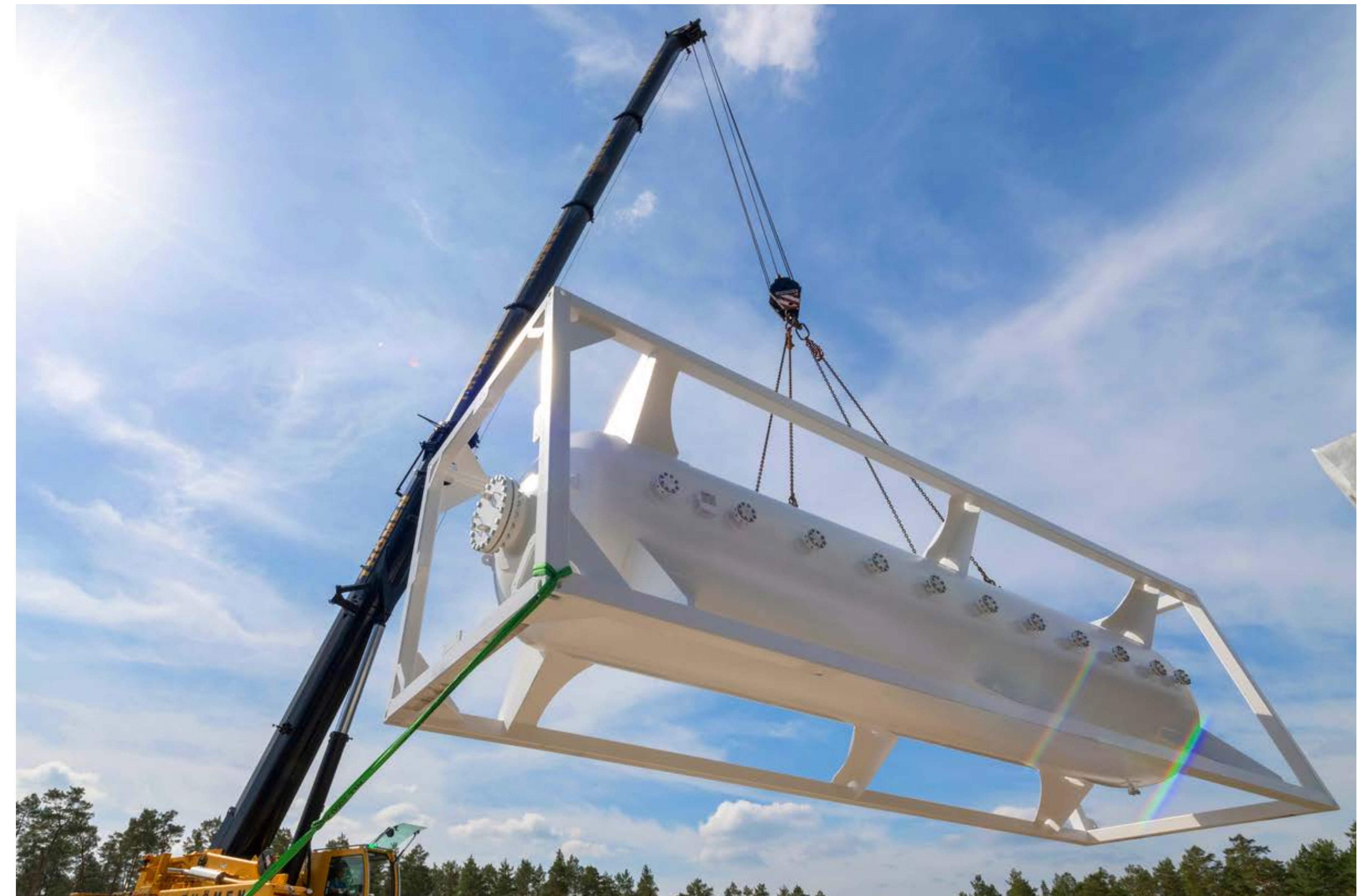
Anlieferung des 60-Kubikmeter-Tanks durch einen Spezialkran
