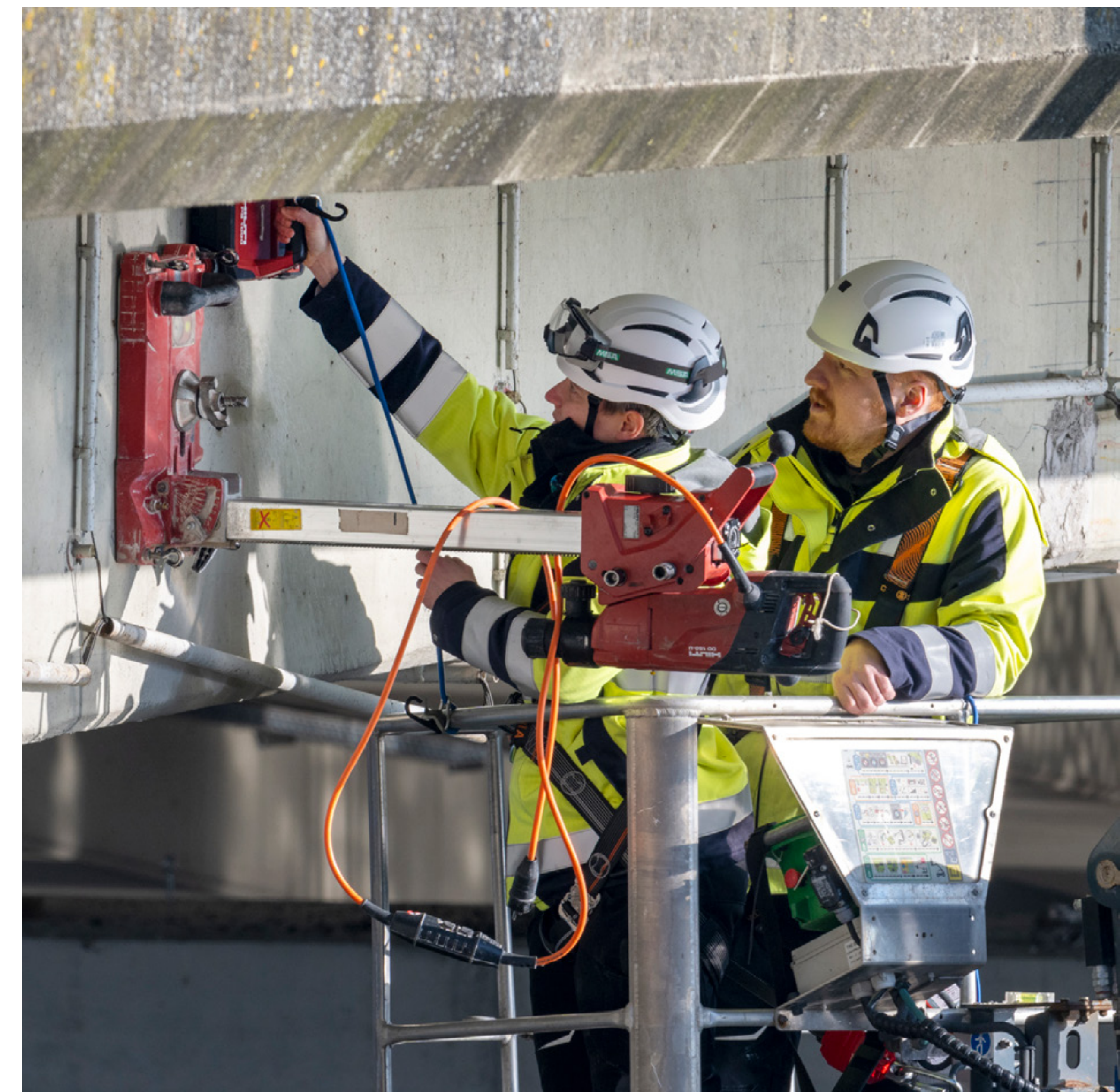
Die Sensoren – Ultraschalltransducer – (l.) werden im Beton der Brücke eingebettet (r.), um Signale zu senden und zu empfangen.
