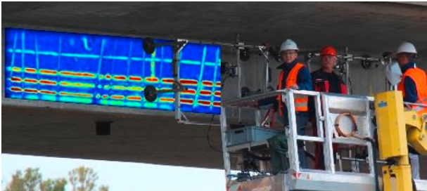
Radaruntersuchungen an einer Brücke zur Bewehrungs- und Spannkanaalortung
