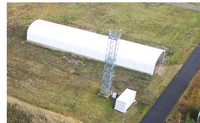
Versuchsanlage zur Untersuchung der Stoffausbreitung tiefkalter Gase auf dem BAM Testgelände Technische Sicherheit (Abmaße: H = 5 m, B = 10 m, L = 40 m)
